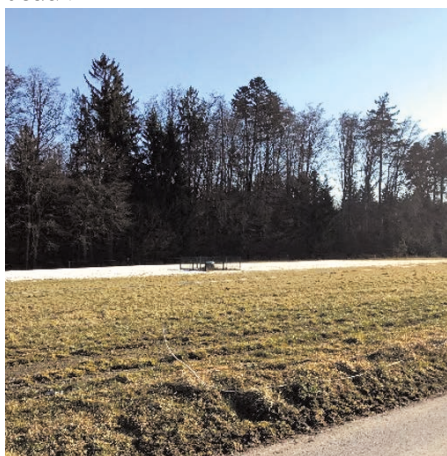
Captage de la source du « Gran Pra » (utilisée comme eau potable).
